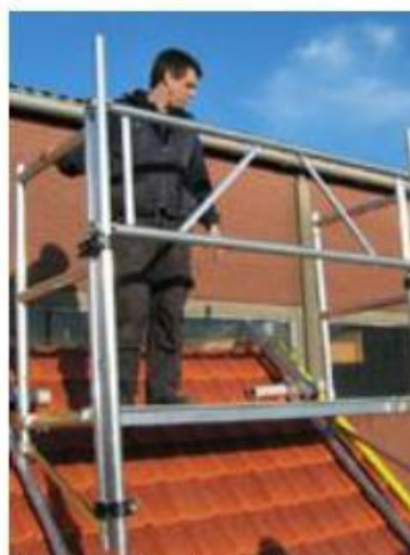
Dubbele leuningschoor plaatsen. De set inclusief kantplankset
