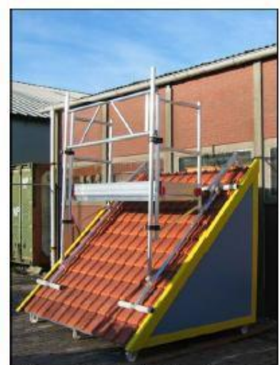
Dubbele leuningschoor plaatsen. De set inclusief kantplankset
